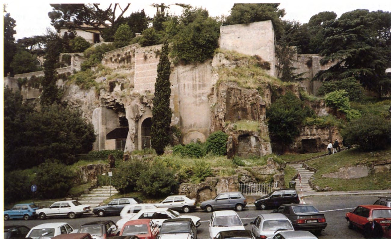
Fig. 8 - Veduta panoramica della Rupe Tarpea (Campidoglio); in primo piano in basso a destra è visibile il contatto tra unità litotecnica litoide (Tufo litoide lionato Auct. ) e unità a comportamento «pseudocoesivo» (tufiti Auct. ). (foto: M. Pecci).
