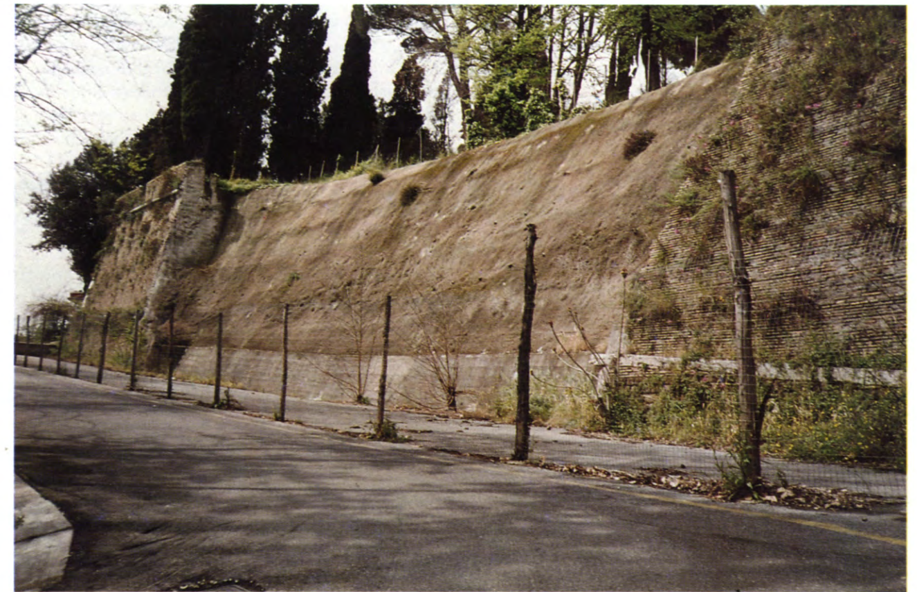
Fig. 5 - Consolidamento delle mura di Villa Sciarra su Via A. Saffi. (foto: M. Pecci).
